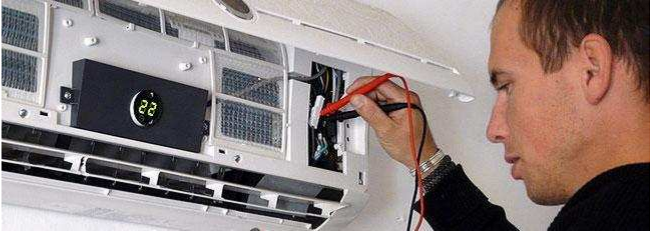
Un técnico instala un aparato de aire acondicionado. / Fotolia
